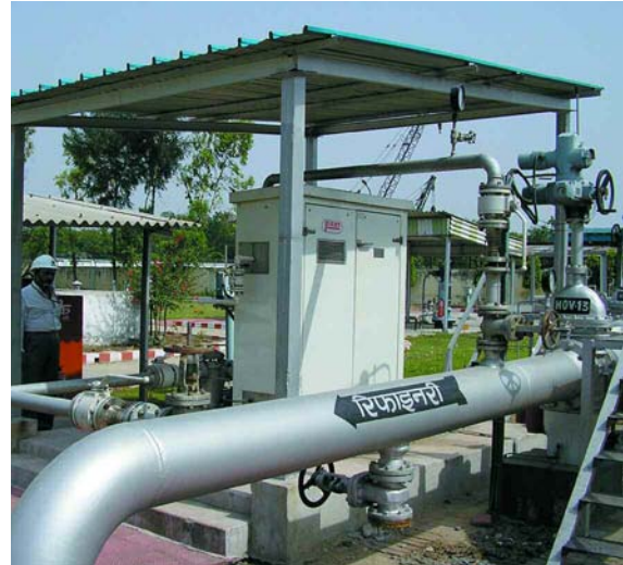
Пробоотборная система CoJetix с системой смешивания JetMix и система отбора проб из байпасной линии «Fast Loop»
